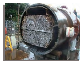
給水加熱器切断
