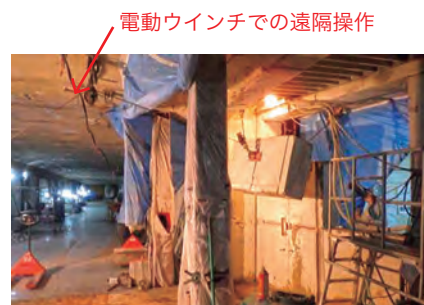
電動ウインチでの遠隔操作
