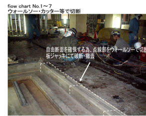
flow chart No.1~7 ウォールソー・カッター等で切断
