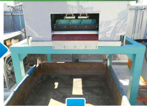
脱水機の下にダンプを設置
