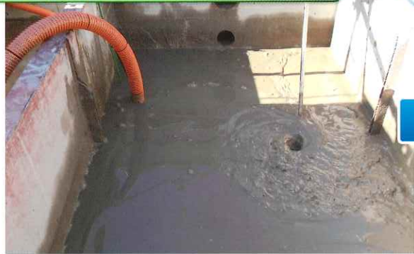
汚泥水を自動で脱水機に移送
